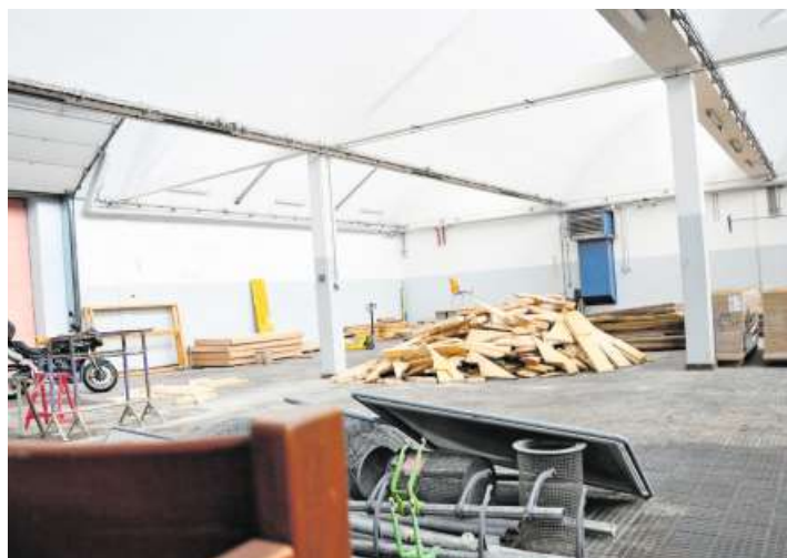
Noch liegen in der Kranenhalle Werkzeuge und Material, bald aber sollen hier Konzerte steigen. Bilder: Nathalie Wolgensinger
